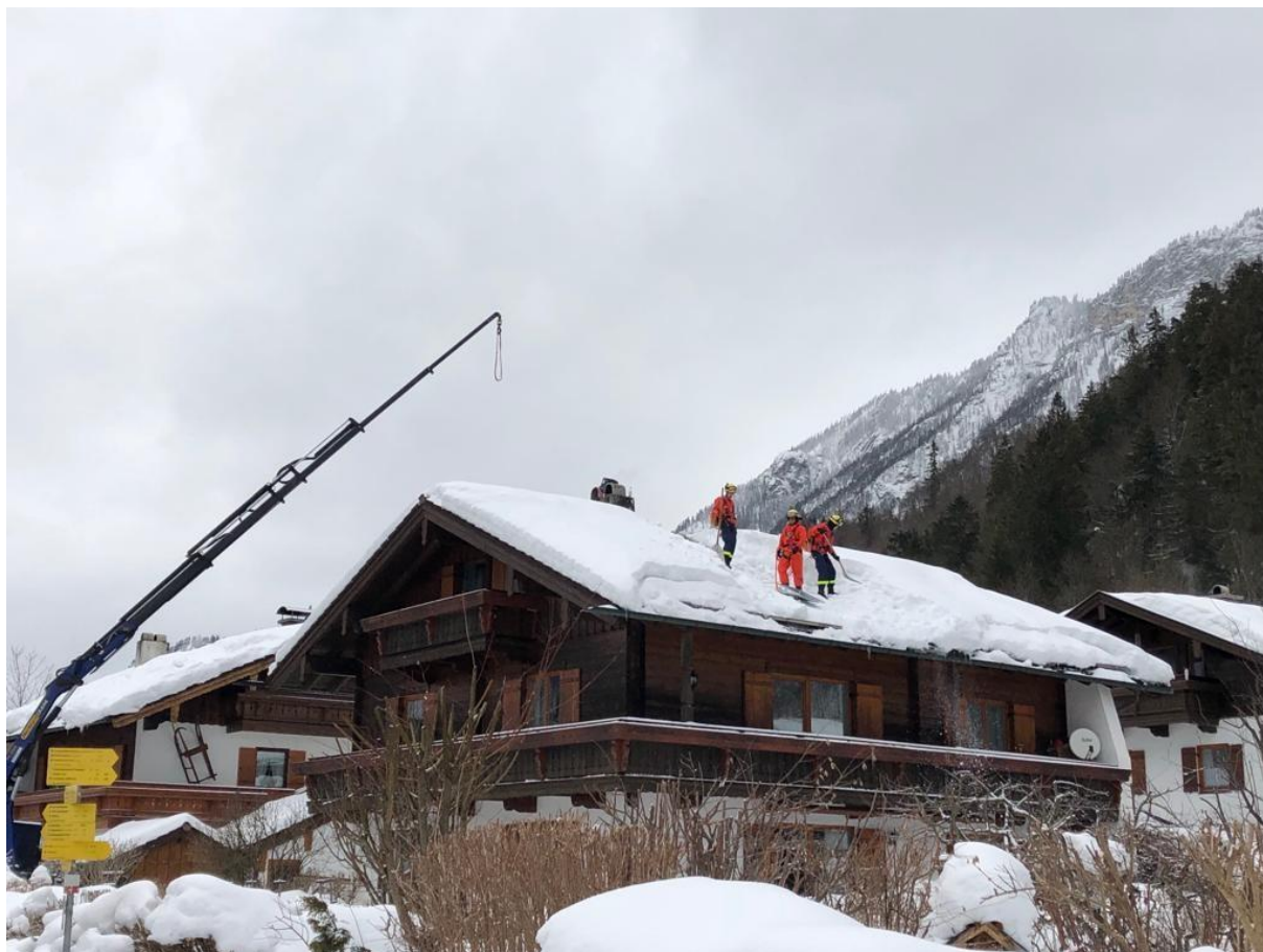
Mitglieder der Freiwilligen Feuerwehr beim Abschaufeln eines Daches.
